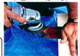
鉄面の素材を露出させる (電動グラインダー使用)
