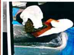
浮き錆を除去する程度 (金属タワシ使用)
