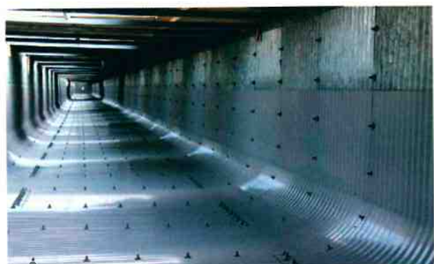
施工後の写真
