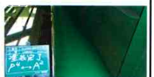
⑥M3001 施工完了
